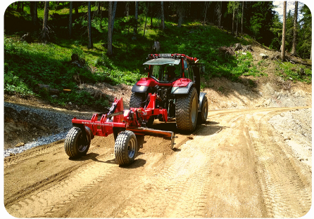
Strassenprofil instandstellen
